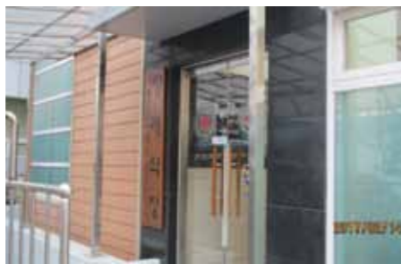
写真5:葬儀場の入り口。左側奥の灰色の建物は病院の建物。2つの建物は渡り廊下で直結している。
