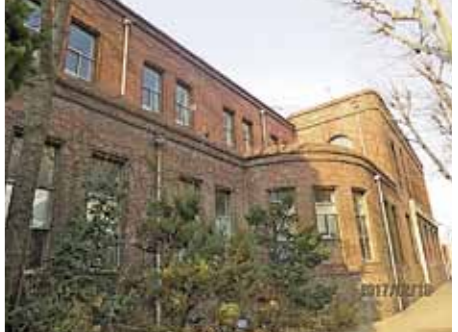
写真3 : 装飾が少なくシンプルな茶褐色煉瓦表装の四角い建物に最上階は随所にアーチ窓を組み込んでいるデザインが秀逸。これほど荘厳で凛々しい姿の病院建物は多くない。韓国の医療の歴史を経験してきた竣工88年目の病院建物。
