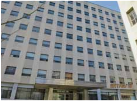
写真9：閉鎖された中山大学附属龍山病院。9階建ての白い巨塔。病院として27年間使用された。大学病院は土地建物の所有者KOREALの要請で移転せざるを得なくなり転出。新しい病院(新築予定)はいまだ開院されず病院建物はフェンスで囲われて閉鎖されたままである。
