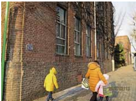
写真5：2月のソウルの朝は冷える。湿度が低いので、寒いというよりも、冷たい、痛いという感じであった。建物の壁に掲げられた「ソウル広域市龍山区漢江路3街」という住所表記がいかにも大陸的。この建物の煉瓦は長手だけの段と小口だけの段とを一段おきに積むイギリス方式。壁角の半円カーブは積むのはきっと技術を要するのだろう。
