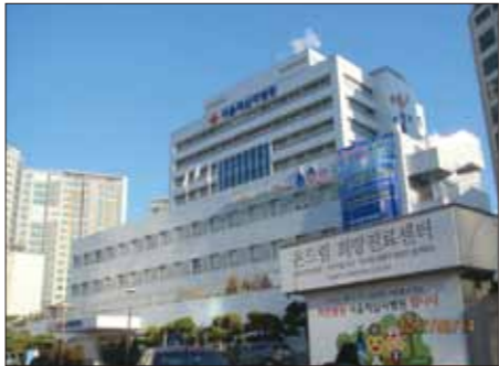
写真1:ソウル赤十字病院。4階建ての旧館と11階建ての新館(共に地下1階)。新館の後ろに隣接する葬儀場、立体駐車場で構成される。旧館の建物のcornerstone(礎石)は1986年であつた。31年前の建物になる。第二次世界大戦中は朝鮮半島で最も大きい病院であつた。
