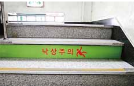
写真11: ヒエン病院の2階から3階に向かう階段。一目瞭然。この病院は高齢者の患者が入院している療養病院。
